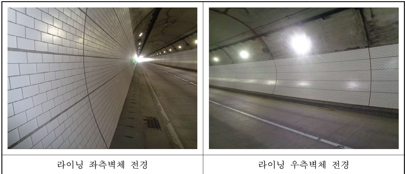
【사진 3.5】 터널 라이닝 측벽부 전경
