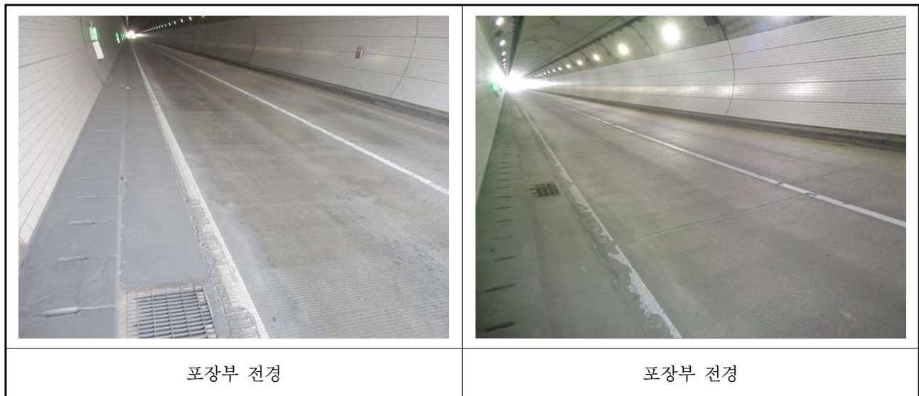
【사진 3.13】 터널 포장부 전경
